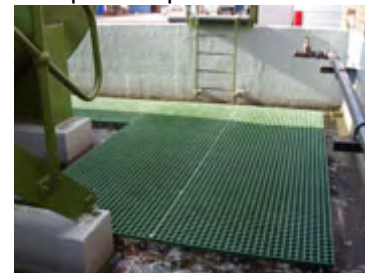
Rejilla instalada en zona de contención de almacén de petróleo.
