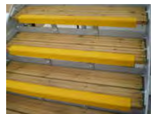
Cantoneras instaladas en peldaños de madera
