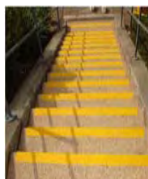
Instalado en peldaños de hormigón.
