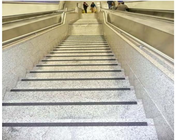
Los productos **PlusGrip** son fabricados en material sintético a base de fibras de vidrio, estabilizados por rayos ultravioletas, con superficie de carburo de silicio muy antideslizante.
